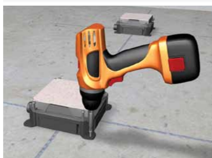
Закрепите монтажные коробки
